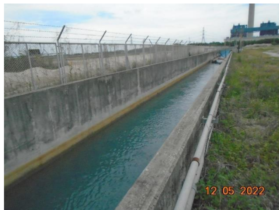
รูปที่ 2-11 รางระบายน้ำทะเลของโครงการ
