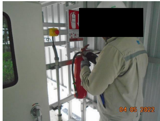
รูปที่ 2-48 การตรวจสอบอุปกรณ์ดับเพลิงประจำเดือน
