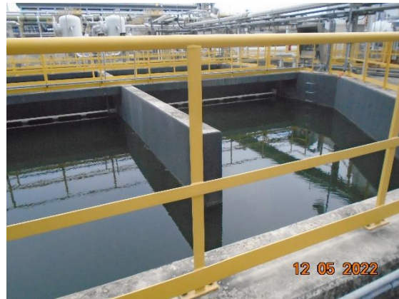
รูปที่ 1-11 ระบบ CPI Separator
