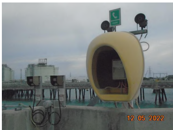
อุปกรณ์แจ้งเหตุฉุกเฉิน (Manual Call Point) บริเวณท่าเทียบเรือ
