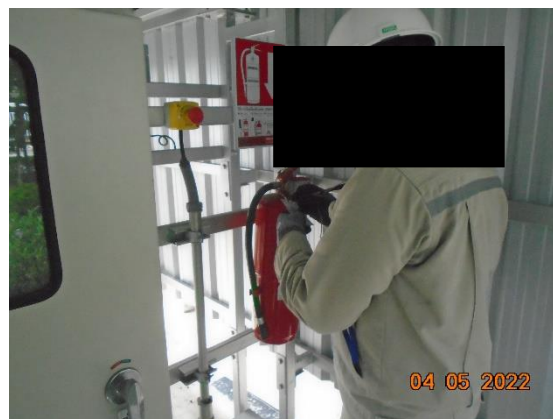
รูปที่ 3-147 อุปกรณ์ดับเพลิงและตัวอย่างการตรวจสอบถังดับเพลิงประจำเดือน
